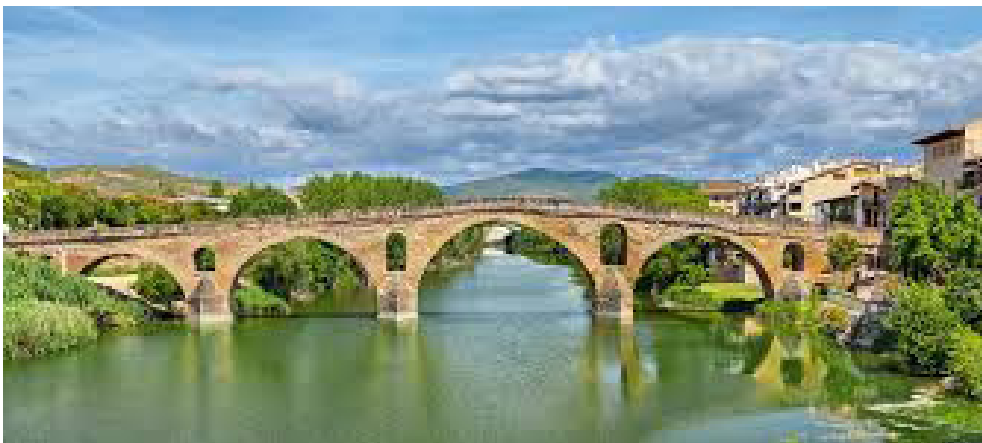
Pont puente la reina.
